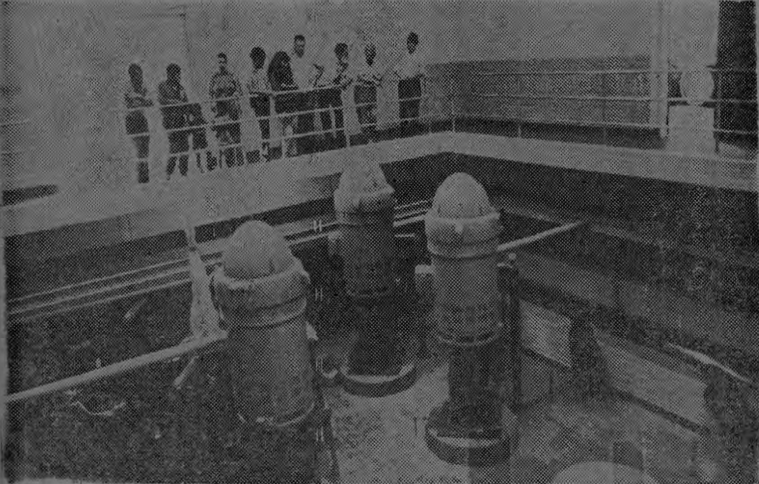
Esta es la sala de máquinas de bombeo que está ubicada en San Antonio de Belén, y que pertenece al proyecto de Puente de Mulas. Cada motor de los tres que se observan y otro que está listo para ser instalado, pesa 5 toneladas. Fue necesario instalar un montagr
